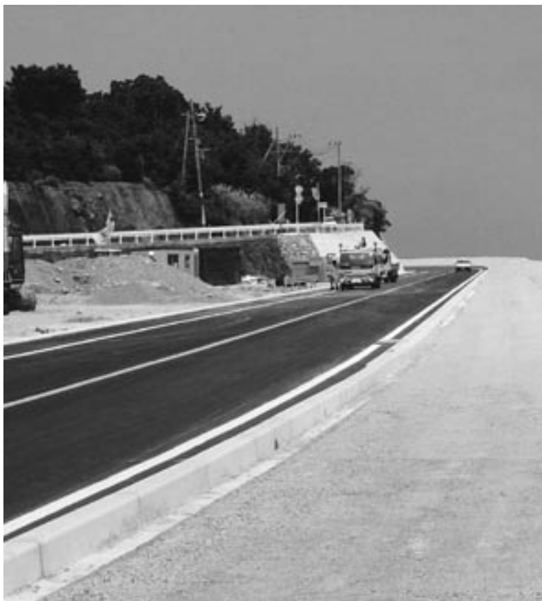
国道 213 号線改良工事 (国東町浜)
